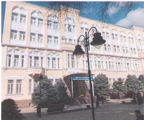
Общий вид на объект культурного наследия
